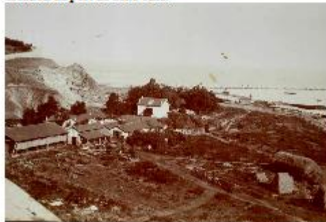
Remblais de la partie est de l'avant-port
