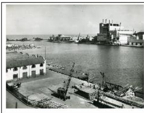
Quai Nord ou Quai Warnier et Quai Sud avec la centrale électrique.
